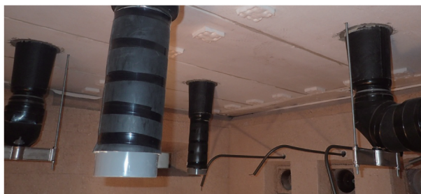
▲試験炉内の様子
