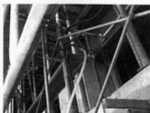
写真13 仮設給水の準備
