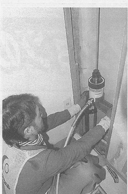
手動油圧式プルッシュジャッキが設置できるスペースさえあれば、狭小スペースでも引き抜きが可能だ
