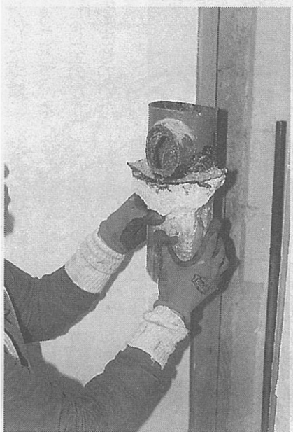
低騒音、低振動、低粉じん 床スラブに埋め込まれている排水管を楽に引き抜ける
