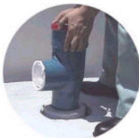
スラブ上面施工例 / 台所流し系統      スラブ上面施工 / 一人施工
