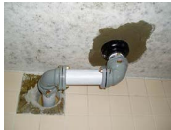
写真-16 下階の天井配管
