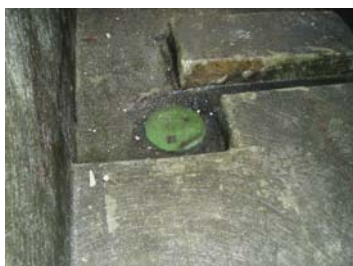
写真-18 FRP 防水／中塗り
