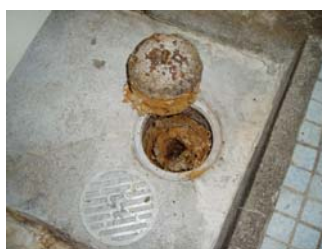
写真-1 床排水トラップ：T5B 錆び付いた本体とワン
