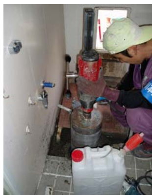
写真-11 ダイヤモンドカッタによるコア抜き
