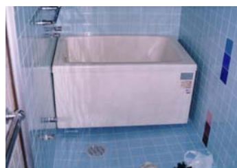
写真-5 バランス釜を撤去し、 大型の浴槽に交換（改修後）
