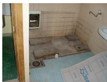
写真-10 バランス釜と浴槽を取り外す
