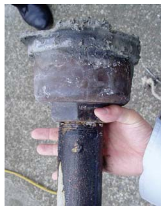
写真-13 防水受けつばをスラブ内に残したまま切り取った T5B 胴部
