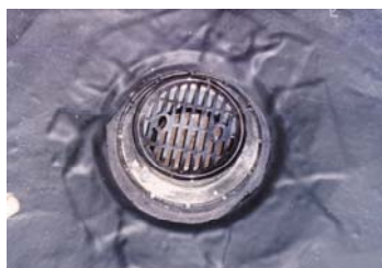
写真-4 新設床排水トラップ：T5B アスファルト防水シート
