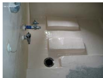
写真-19 FRP 防水／トップコート
