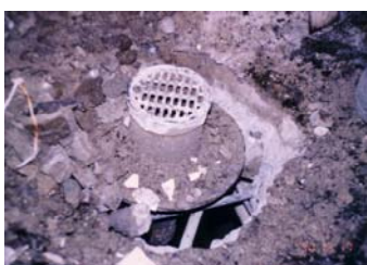
写真-3 既設床排水トラップ：T5B ハツリ作業
