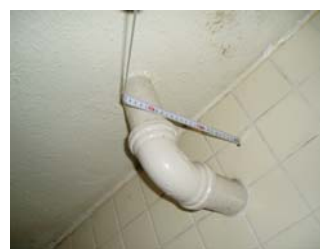
写真-2 ねじ込み式排水管継手 下階の天井配管
