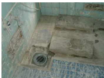
写真-17 FRP 防水／下地処理
