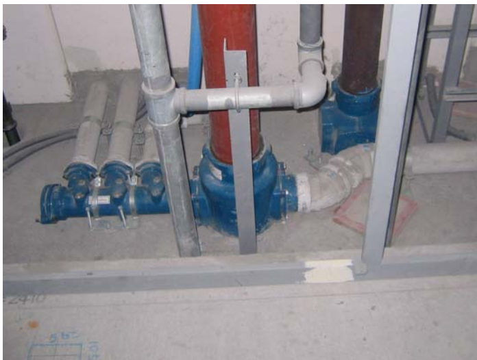
5. パイプシャフト内の納まり
