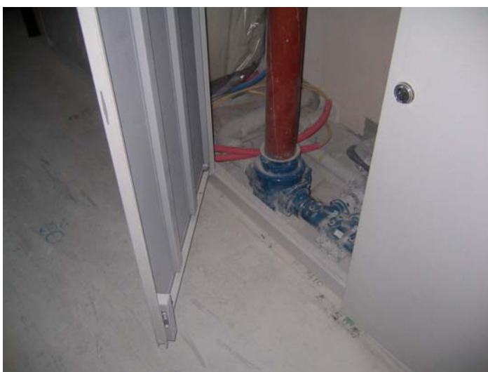
6. パイプシャフト扉を設置
