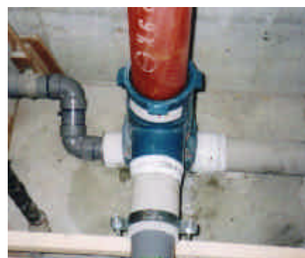
図-5 改修後（汚雑合流立て管） 左：台所流し横枝管 中：汚水横枝管 右：浴室・洗面横枝管
