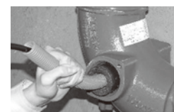
KSGを用いた洗浄風景
